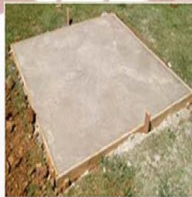
Base pronta para instalação
